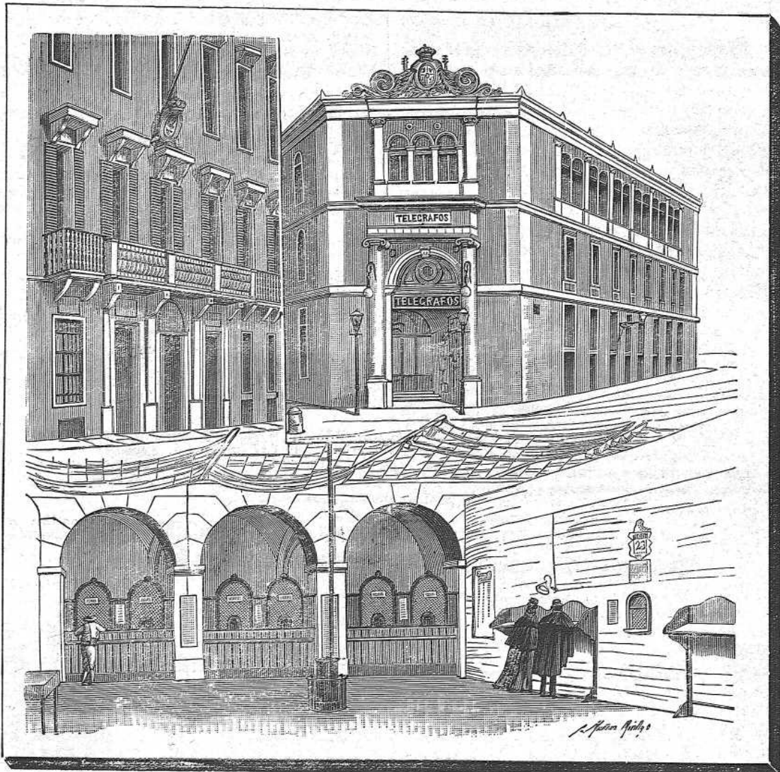
VISTA DE LA CENTRAL DE TELÉGRAFOS
