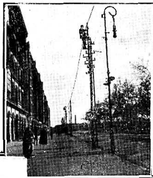
Celadores sustituyendo el ramal antiguo de hilos por cable
