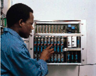
Foto 1 – Subastidor terminal del conmutador
