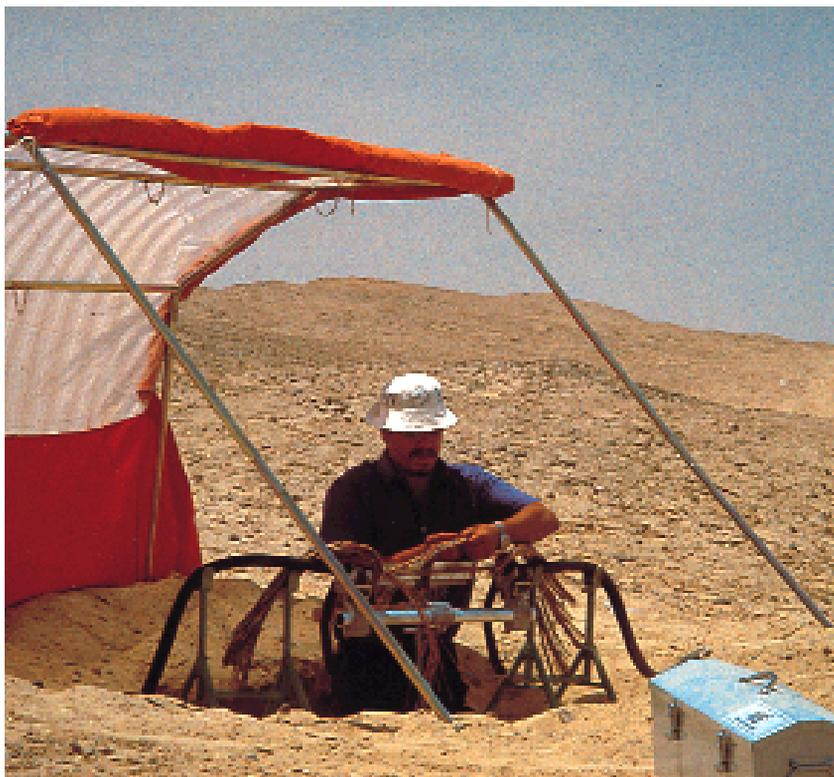
Foto 3 - Empalme de cables en severas condiciones ambientales
