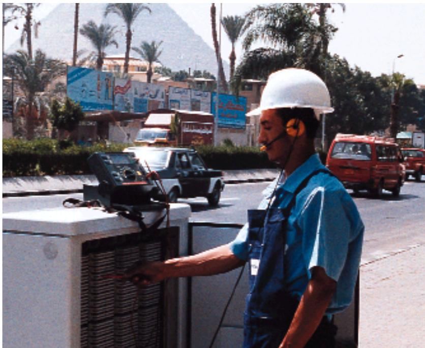
Foto 2 - Prueba de cables en un armario de exterior de transconexión
