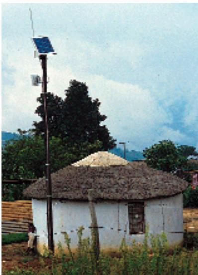
**Foto 7 – Instalación típica DECT en una vivienda rural**
