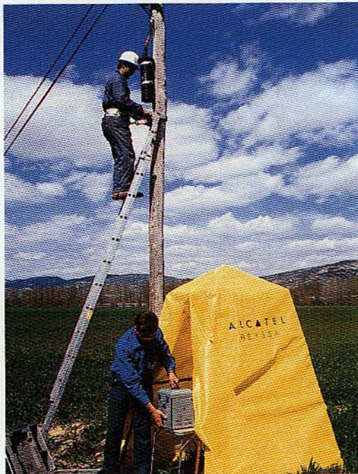
Instalación de la fibra óptica en España.
