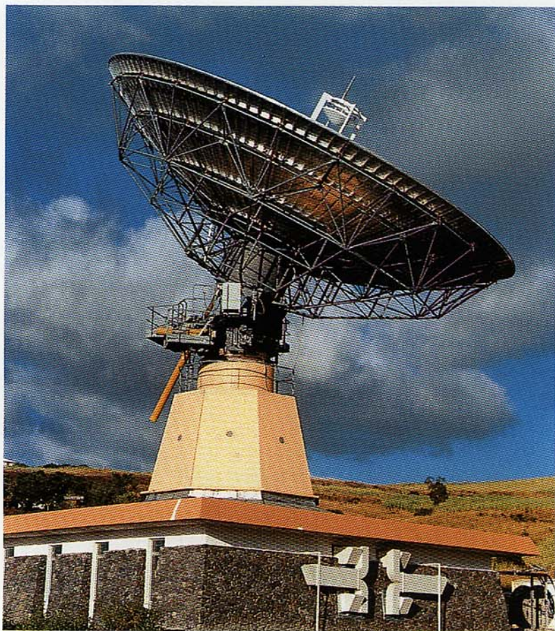
Estacion terrena Standard A.
