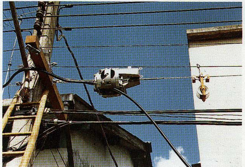
Sujección de un cable aéreo sobre el portador.
