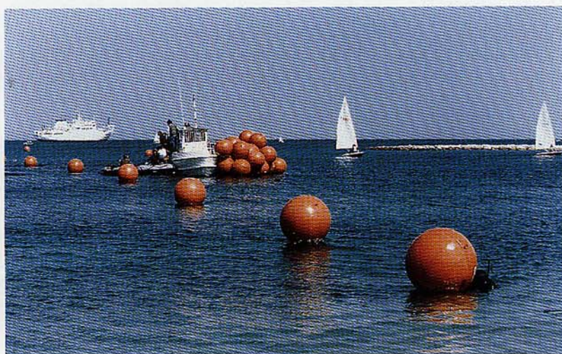
Tendido de un cable óptico submarino.
