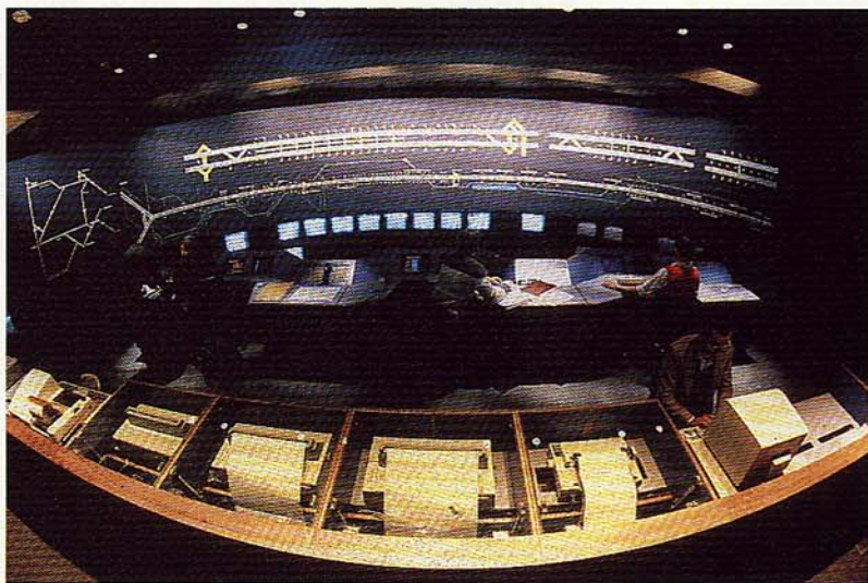
Vista panorámica del centro de control.
