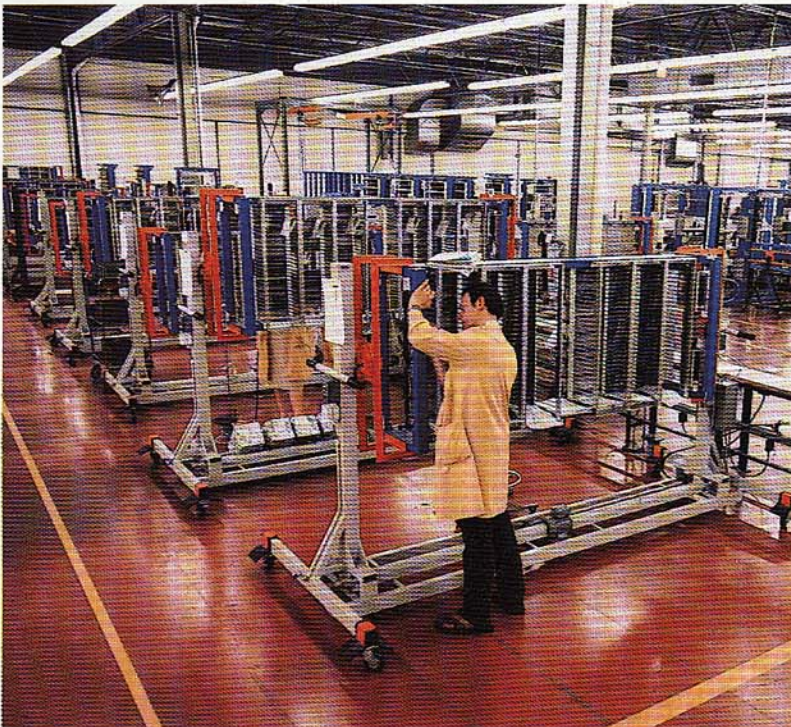
Ensamblaje y cableado de bastidores de una central Sistema 12 en la fábrica de BTM en Geel.
