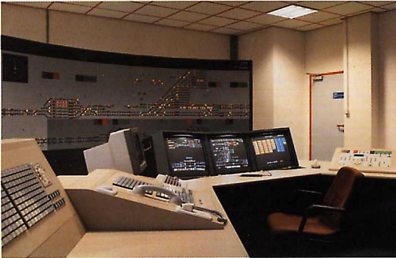
**Sala de control para el sistema de control ferroviario Videopult.**
