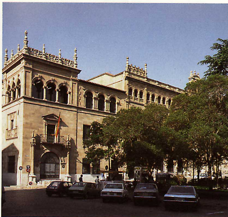
Edificio de Salamanca donde funciona la primera central digital Sistema 12 en España, con capacidad de 10.000 líneas de abonado.
