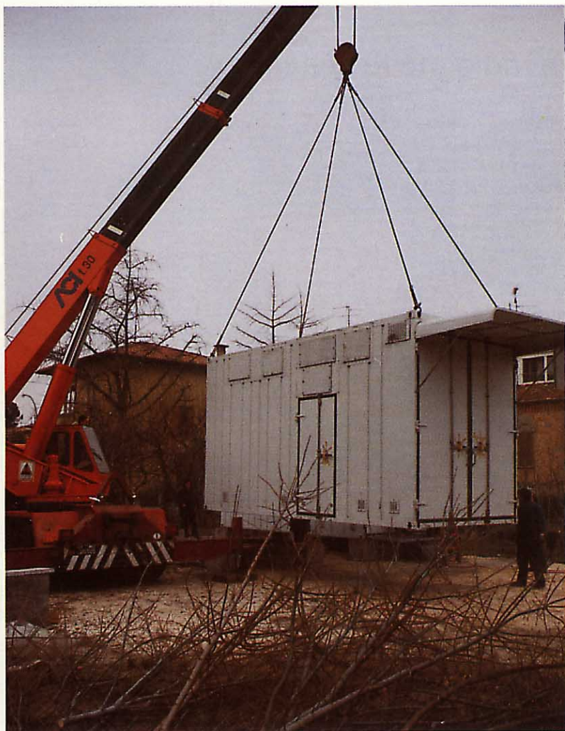
Instalación de un contenedor del Sistema 12. La única preparación necesaria es la construcción de una base de hormigón o, como se muestra aquí, cuatro pilares.
