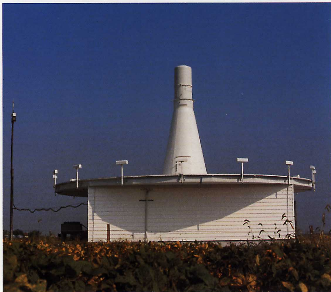
Instalación VORTAC de la segunda generación.
