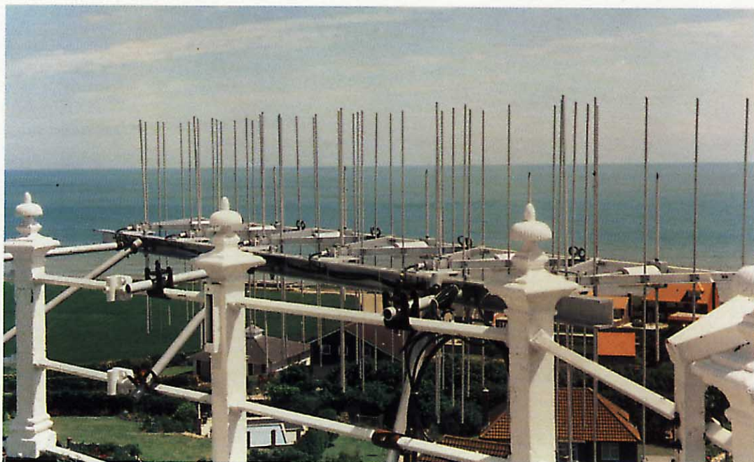
Antena de radiofaro montada en la torre del faro de North Foreland.
