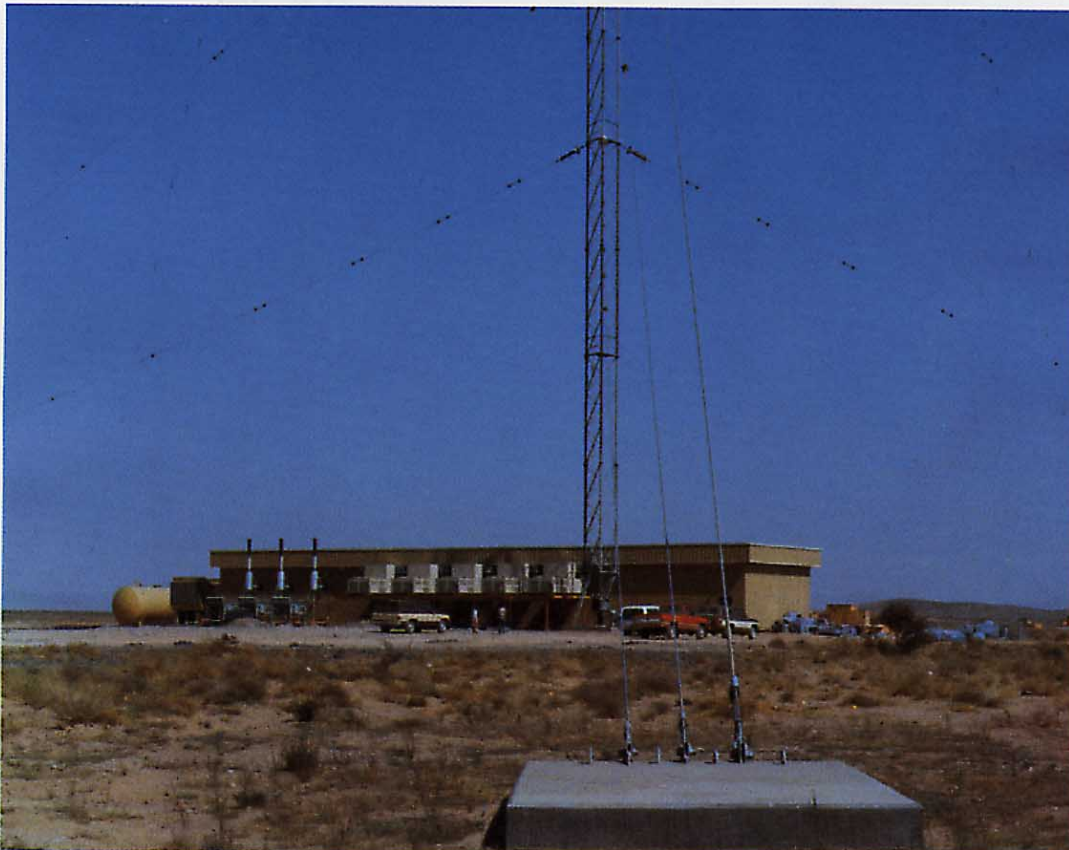
Estación transmisora de Afif en Arabia Saudí.
