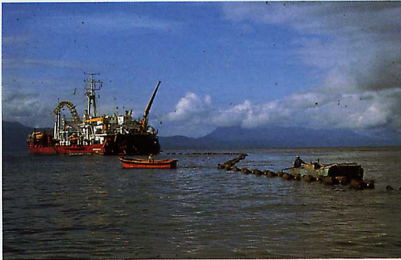
Arrastre hacia tierra de un extremo de cable flotante.
