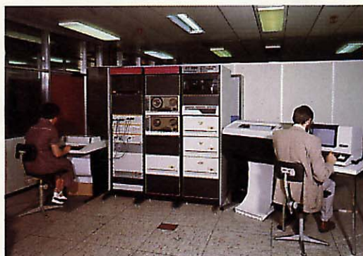
Centro de operación y mantenimiento ITT 1290.
