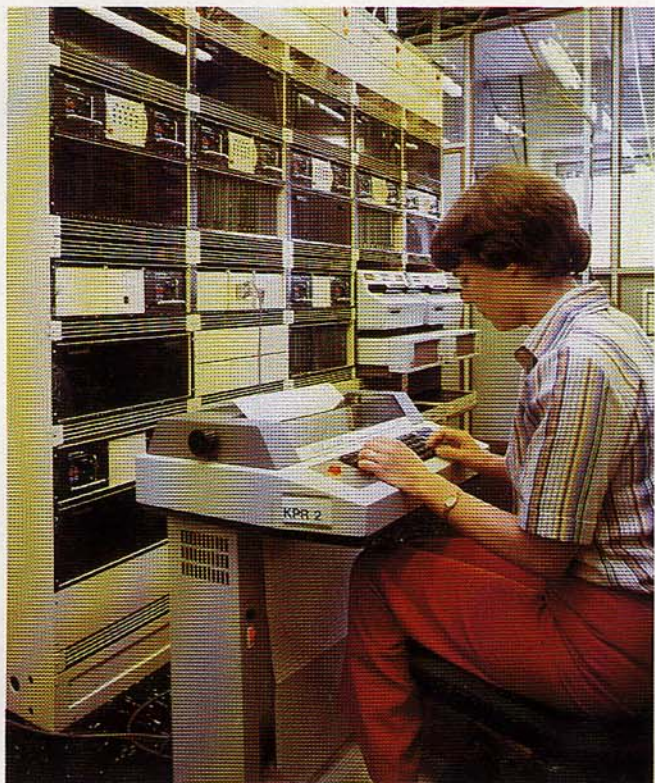
Una operadora de mantenimiento efectúa cambios en las tablas de tarifas y pasos de cómputo mediante el subsistema de diagnóstico y mantenimiento.
