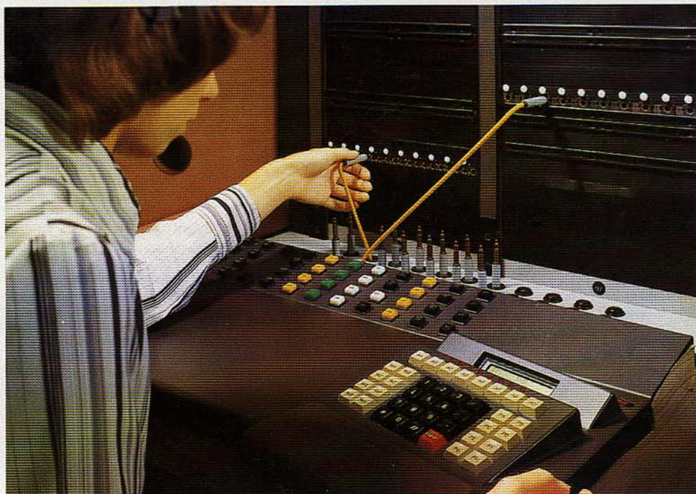
La unidad OPAS-II en operación con una centralita manual.
