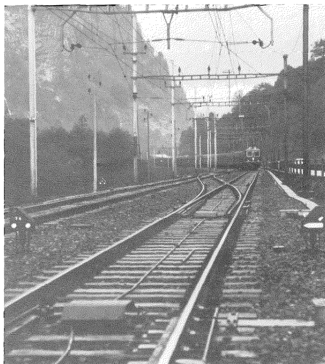
Vista parcial de la línea St. Gotthard mostrando los bucles de línea y un procesador instalado al lado de la vía del sistema de control continuo de trenes LZB L72.
