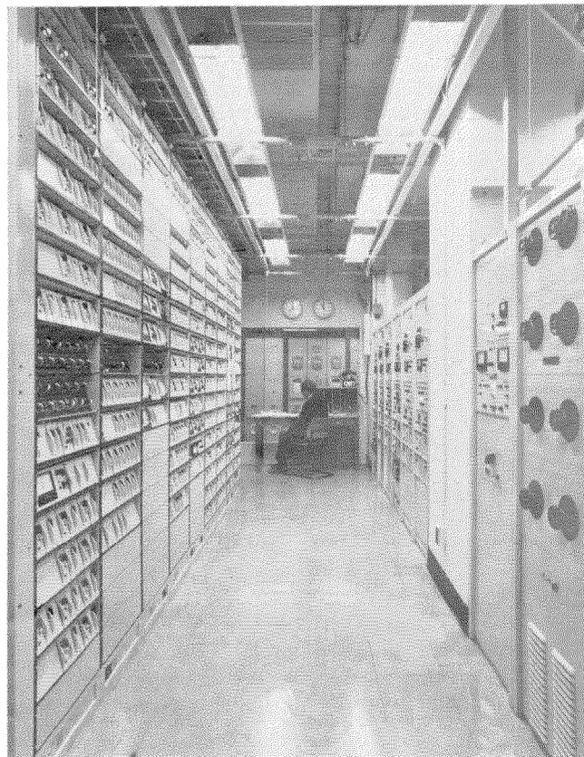
Fig. 2 Filas de transmisión y alimentación de potencia en el terminal de Widemouth.
