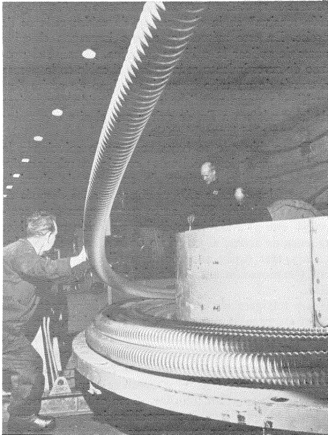
Fig. 8 Arrollamiento de un cable de 400 kilovoltios en un tambor giratorio después de la corrugación de la cubierta.
