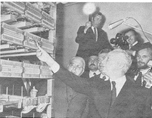
Fig. 2 Funcionarios observando el cuadro de distribución general.
