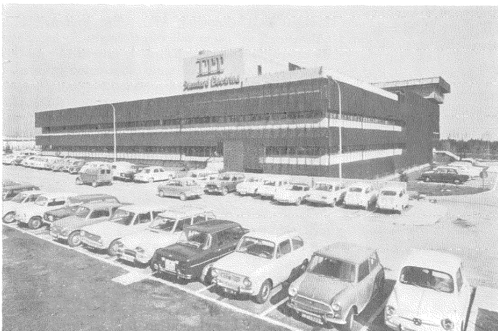
Fig. 4 Nuevo edificio del laboratorio. Vista posterior.
