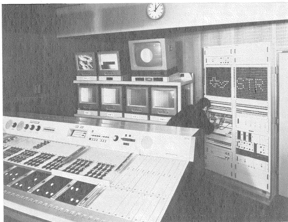
Vista del control de sonido con el pupitre mezclador para 24 entradas, cuadros de distribución con distribuidores de barras cruzadas, paneles de conexión en U y el monitor de control.
