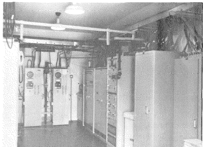
Fig. 5 Edificio de antena.
