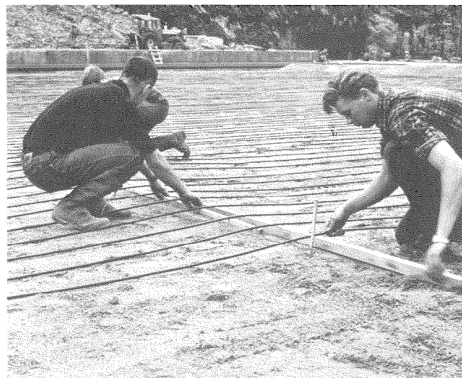
Instalación de cables en el subsuelo para calefacción. Se ajusta la separación entre cables.
