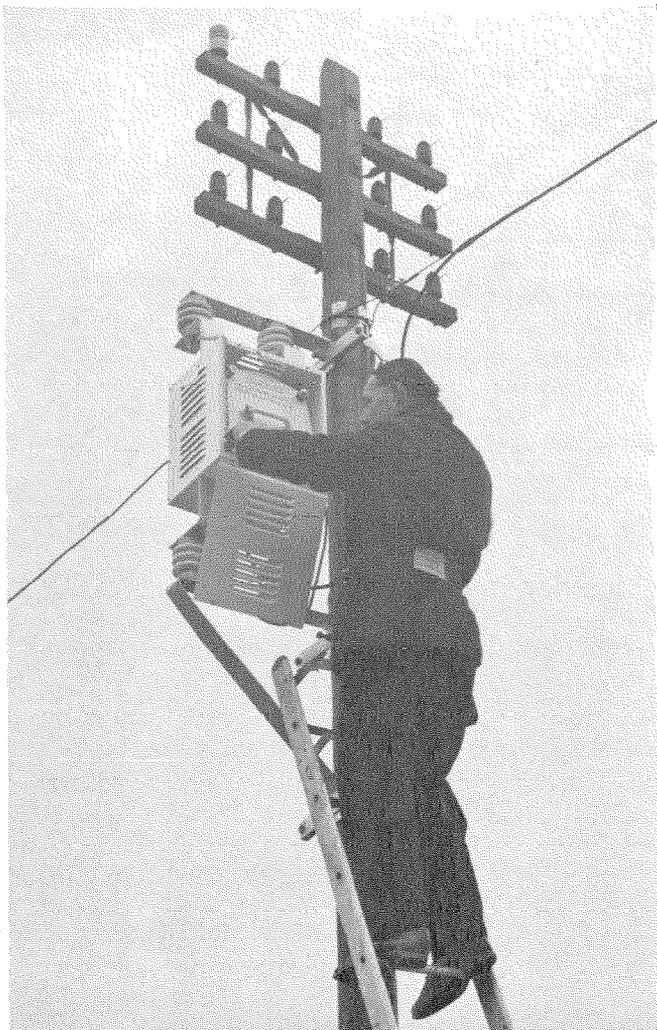
Fig. 5 Fotografía de un repetidor auxiliar montado en un poste.
