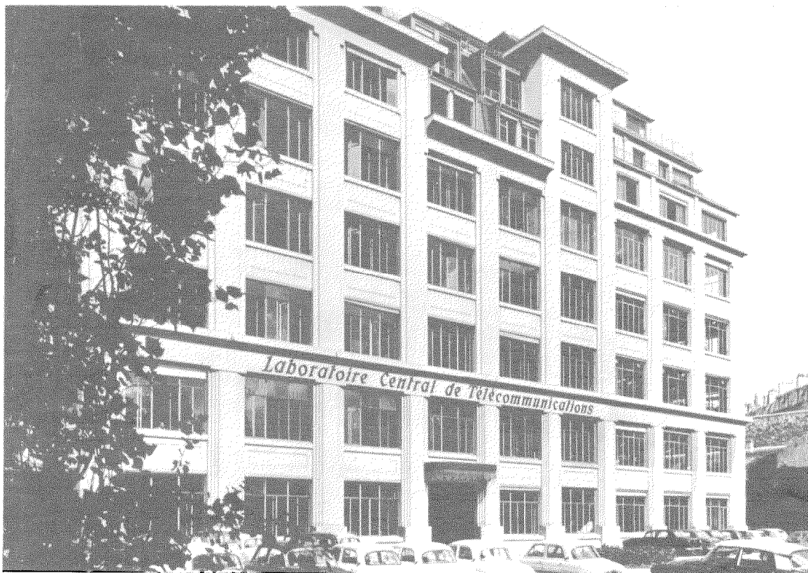
Figure 1—East front of Laboratoire Central de Télécommunications.
