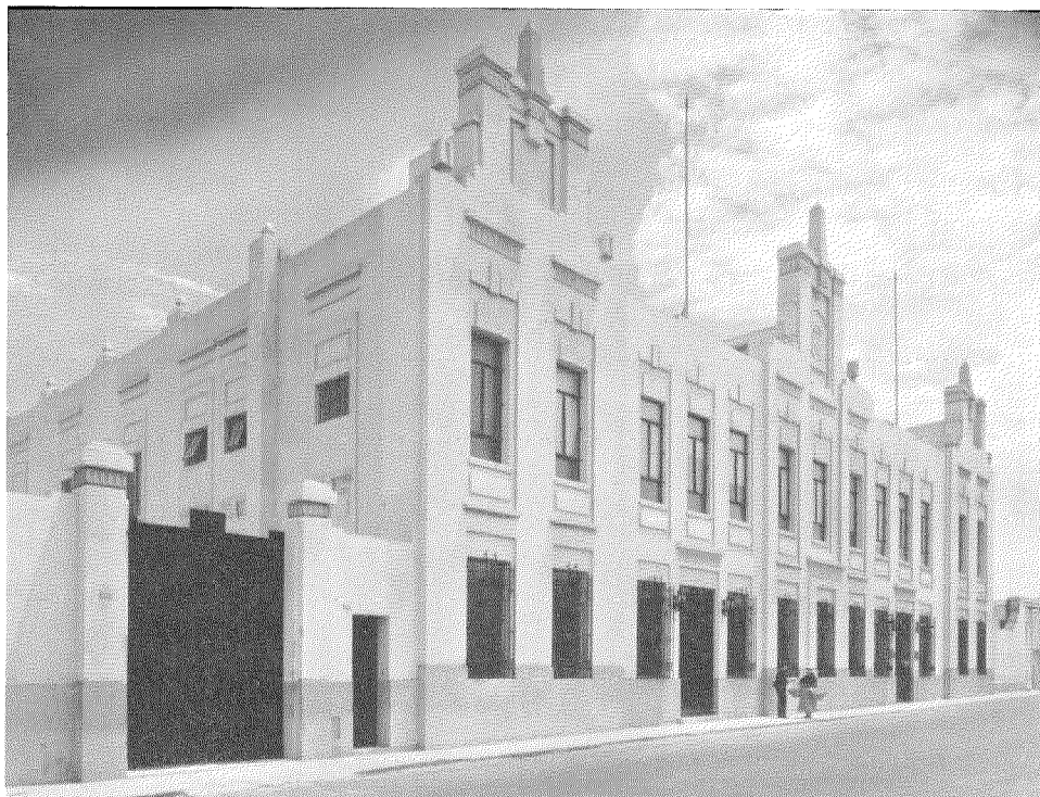
Fig. 2—Washington Automatic Exchange and Headquarters Building of the Compañía Peruana de Teléfonos Limitada.
